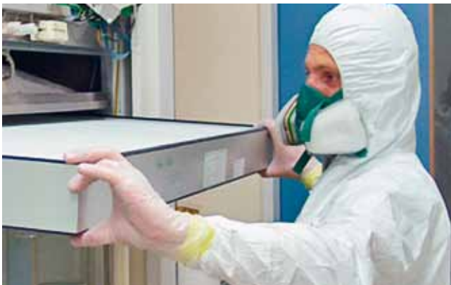
Sehr häufiger Einsatz: Der HEPA-Filterwechsel, alt gegen neu.
