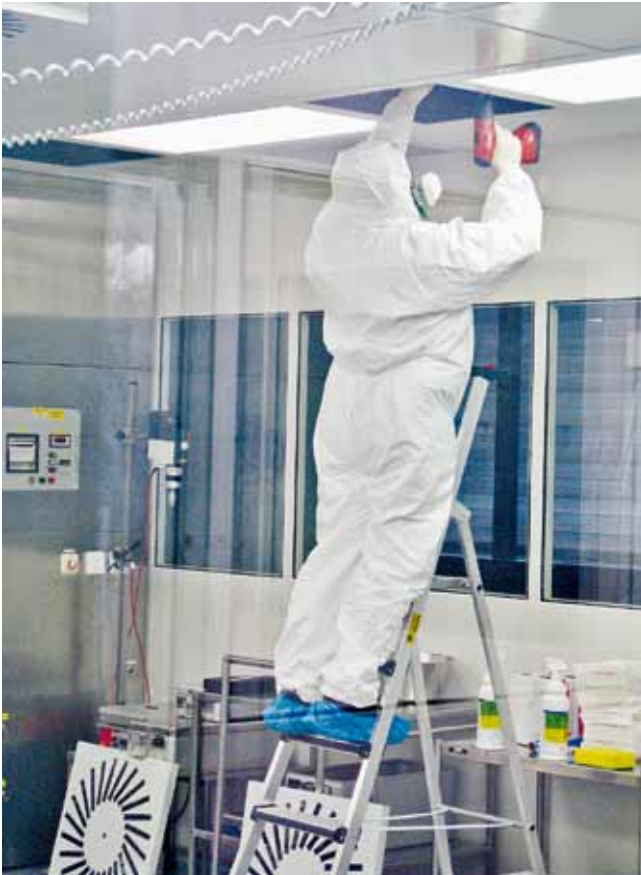
Demontage eines HEPA-Deckenfilters im Reinraum.
