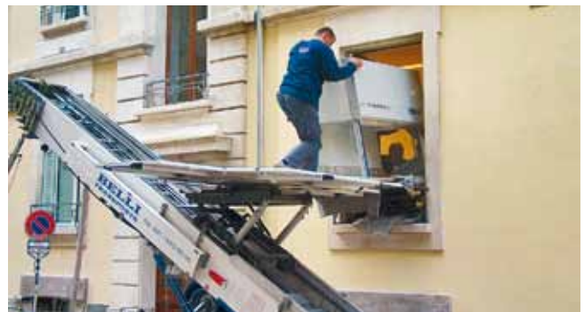
Der Schrägaufzug von aussen hilft bei sehr engen Laborzugängen.
