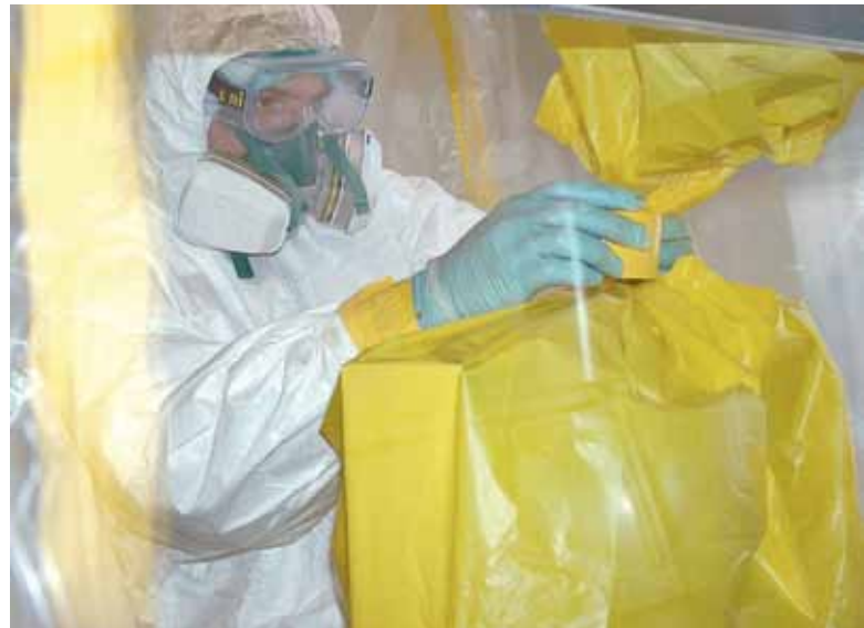
Verpacken kontaminierter Defektteile (hier im Folienzelt).
