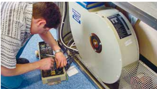
Elektrische Kenntnisse auch von älteren Anlagen sind unser Plus.
