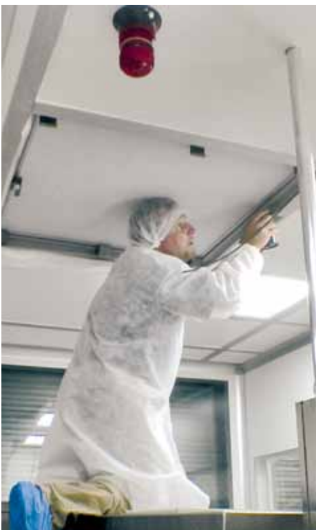
Der Techniker bereitet einen Deckenfilter zur Messung vor.
