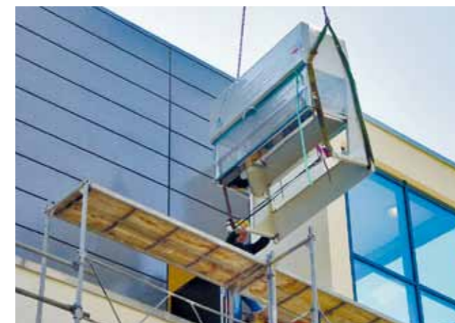
Les équipements lourds peuvent également être livrés par une grue.
