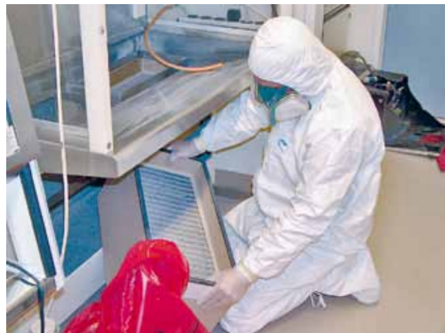
Le remplacement de filtres HEPA contaminés exige beaucoup de diligence et un équipement de protection.
