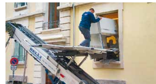
L'utilisation de l'ascenseur incliné par l'extérieur est utile en cas d'accès très étroits.
