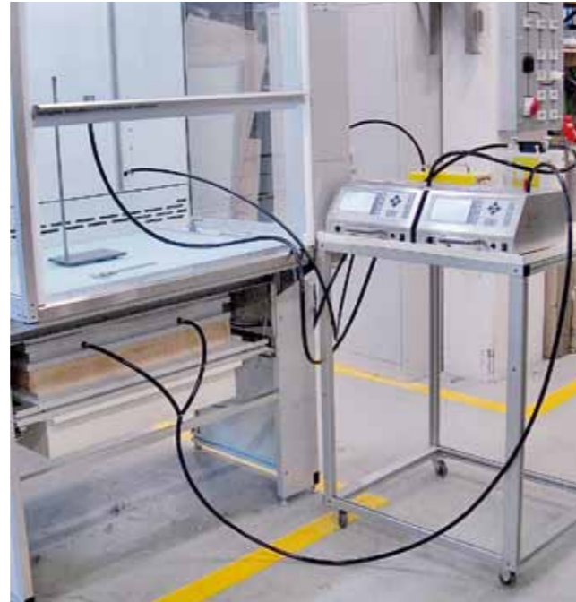
Travaux préparatoires pour la mesure de l'intégrité des filtres HEPA d'une Skanair® Workstation AS.
