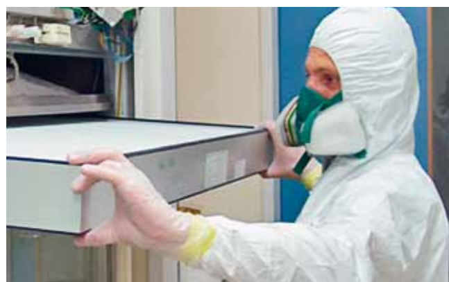
Une intervention très fréquente: le remplacement des filtres HEPA usagés.
