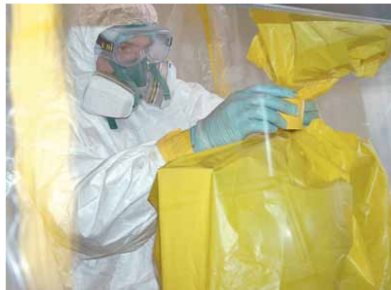
Conditionnement de pièces défectueuses contaminées (ici, sous une bâche).
