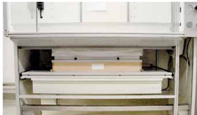
Substructure ouverte d'une sorbonne Skanair® Workstation avec des filtres purifiant l'air recyclé (filtre HEPA et charbon actif).
