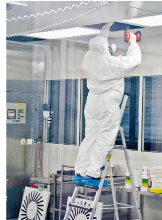
Démontage d'un filtre plafonnier HEPA dans une salle blanche.
