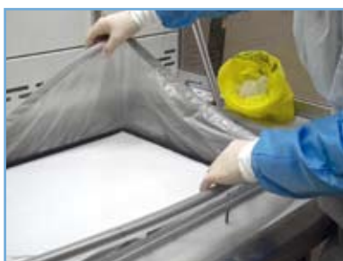
Changement de filtre avec faible risque de contamination grâce au set AS (type 3)
